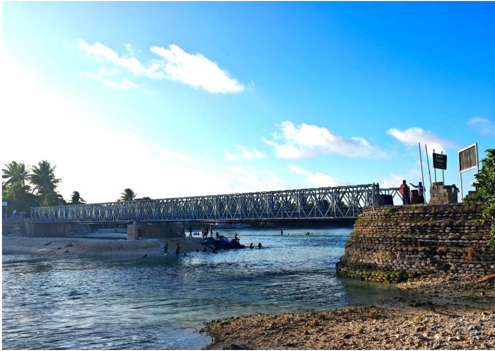
中铁一局承建的布塔桥修缮工程
