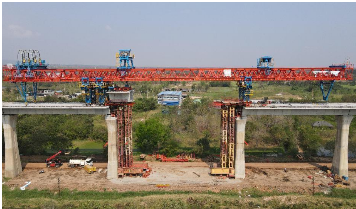
建设中的中泰铁路
