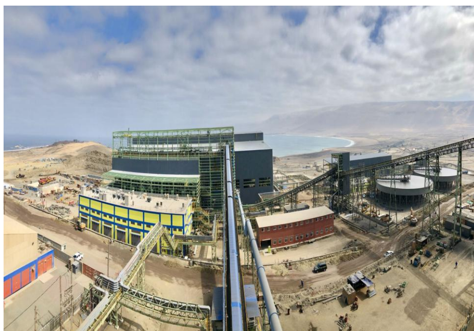
首钢秘铁二期扩建工程投入使用
